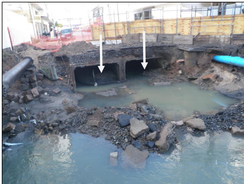
Figura 07 – Foto sobre a Rua. Vitório Serafim, encontro da etapa concluída, com a caixa de transferência 16, parte do Lote 2 do projeto executivo de macrodrenagem do rio Criciúma.
