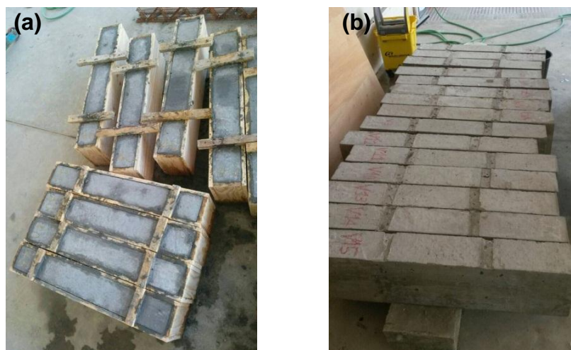
Figura 05 – (a) Vigas após a concretagem. (b) Vigas após a desforma.
