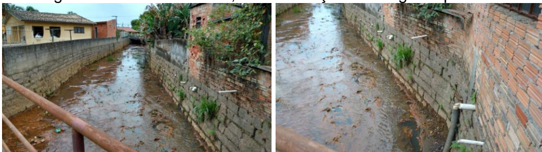
Figura 5: Rio contaminado, com tubulações de esgoto aparentes
