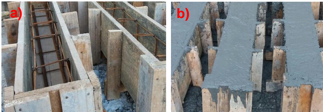
Figura 04: a) Fôrmas de madeira com as armaduras; b) Vigas concretadas.
