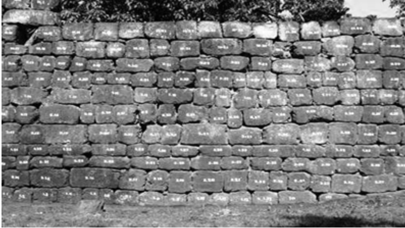
Figura 2 - Consolidação de muro em São Lourenço Mártir
