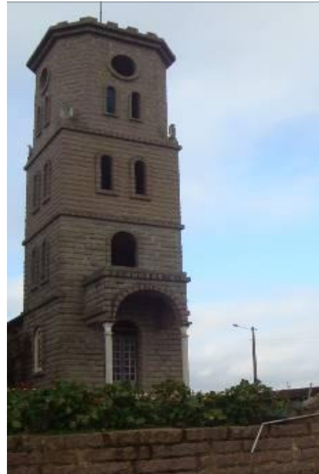
Figura 11 – Torre do Castelo Belvedere
