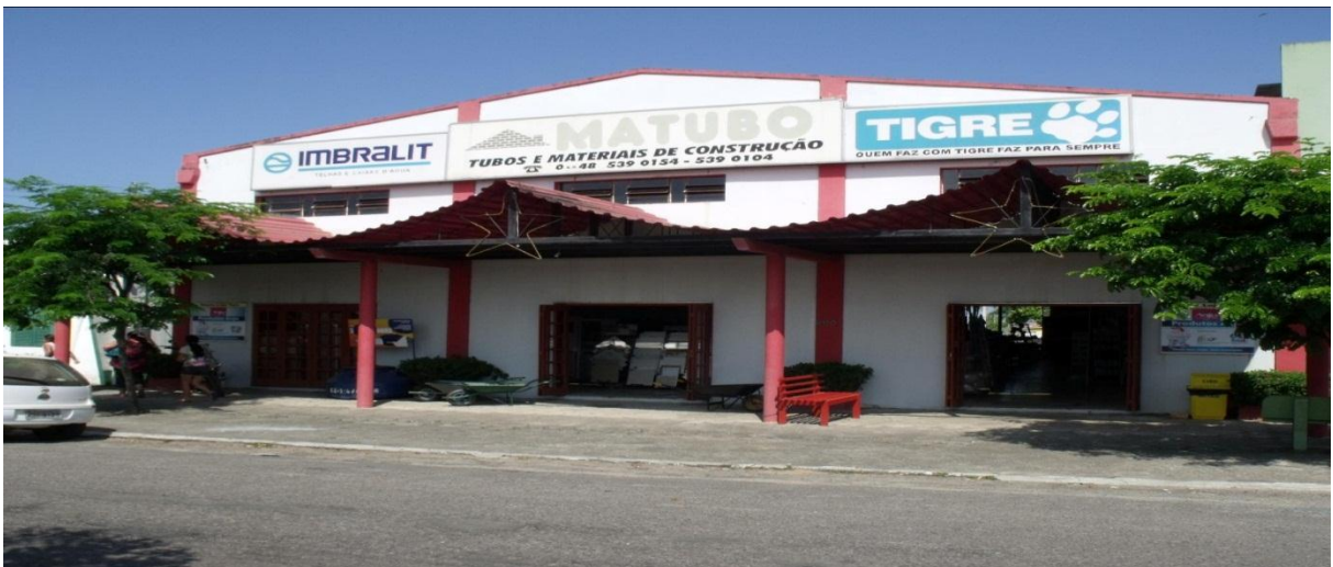
Figura 14 - Fachada da loja.
