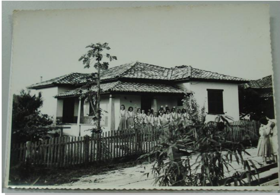
Figura 2: Casa Assistencial São José Residência das Pequenas Irmãs da Divina Providência (Rio Maina), em [1957?] Fonte: Acervo Fotográfico Colégio MTM
