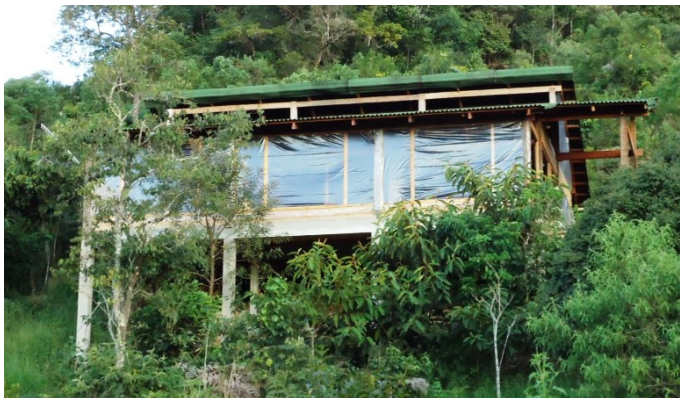
Figura 18: Casa de morador (terceira casa construída – em construção)
