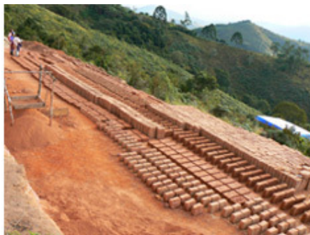
Figura 16: Produção de tijolos de adobe em Terra Una
