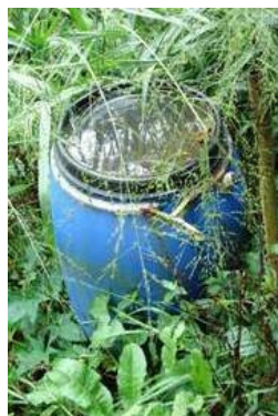
Figura 22: Sistema de filtros
