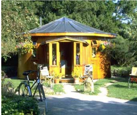
Figura 1: Primeira moradia construída com barril de uísque em Findhorn
