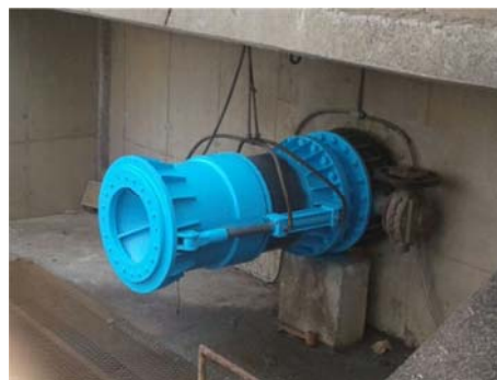
Figura 1–Válvula dispersora barragem rio São Bento
