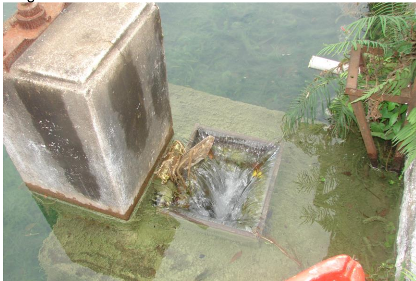
Figura 3 – Extravasor do reservatório em funcionamento.
