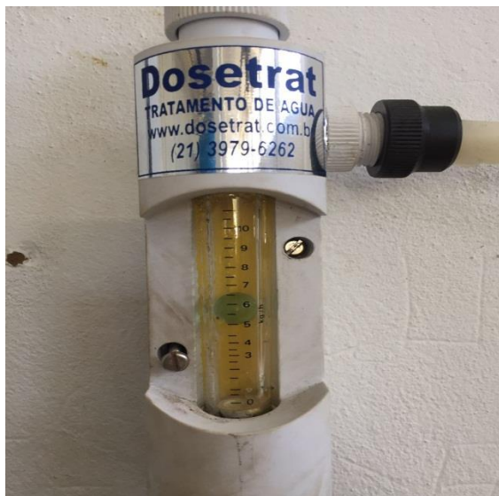
Figura 21 – Dosagem de Gás Cloro.
