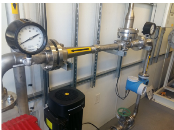
d) Detalhes do tubo de Venturi.
