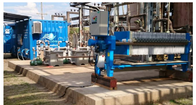
b) Detalhes dos reatores e do container com os geradores de O 3 e do filtro prensa.
