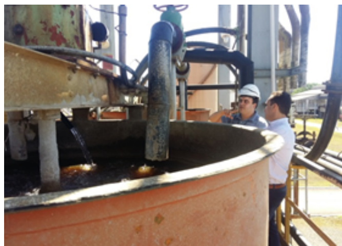
f) Detalhes da DAM tratada na saída do filtro prensa.
