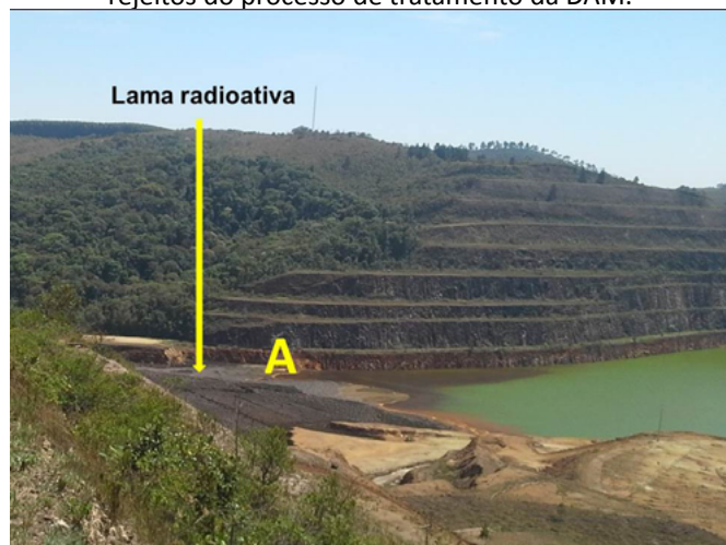
Figura 7 - Corpo A da cava da mina onde são depositados rejeitos do processo de tratamento da DAM.
