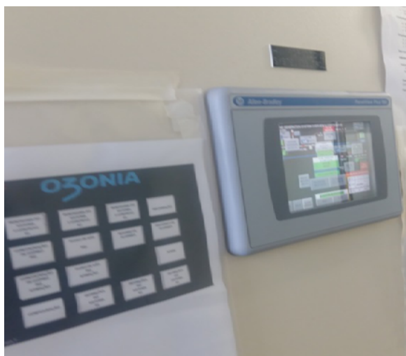
e) Detalhes do painel de controle.
