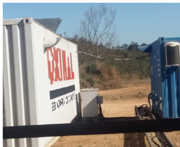
a) Vista geral dos containers do concentrador de oxigênio e dos geradores de ozônio.
