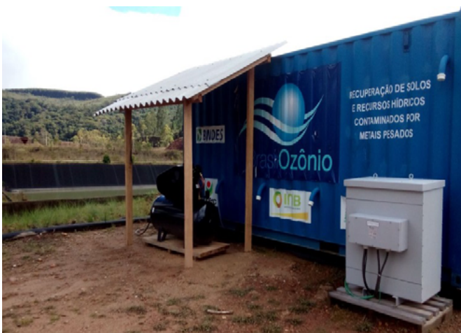
e) Aspecto do compressor de ar e transformador de energia.
