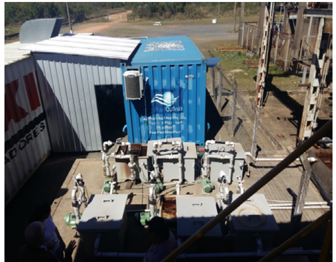
a) Detalhes dos reatores e do container com os geradores de O 3 .
