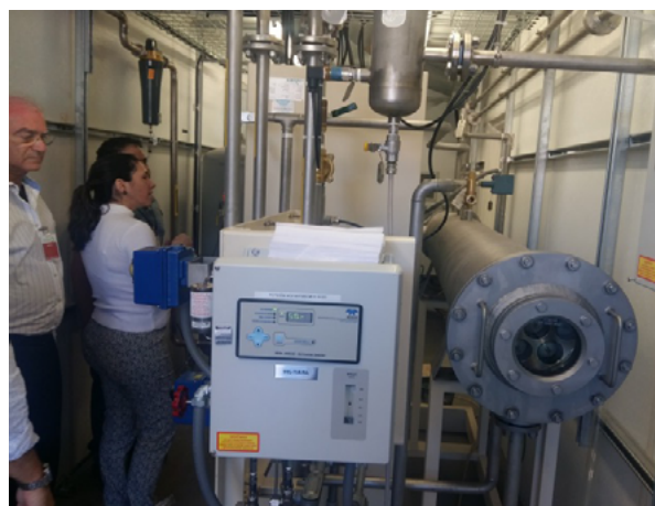
c) Detalhes do gerador de ozônio.
