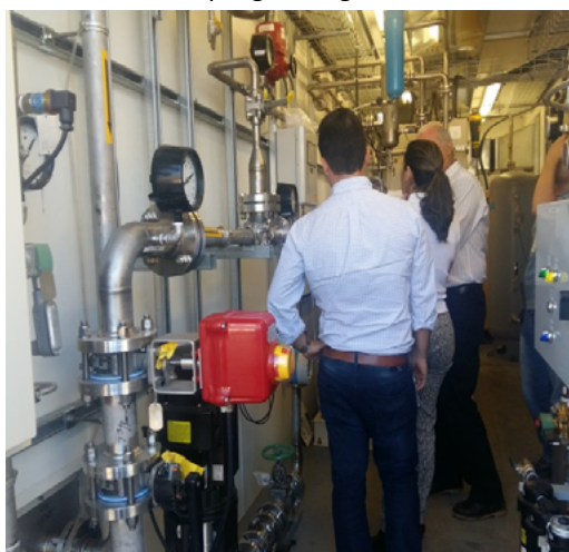
a) Detalhes do interior da planta-piloto.
