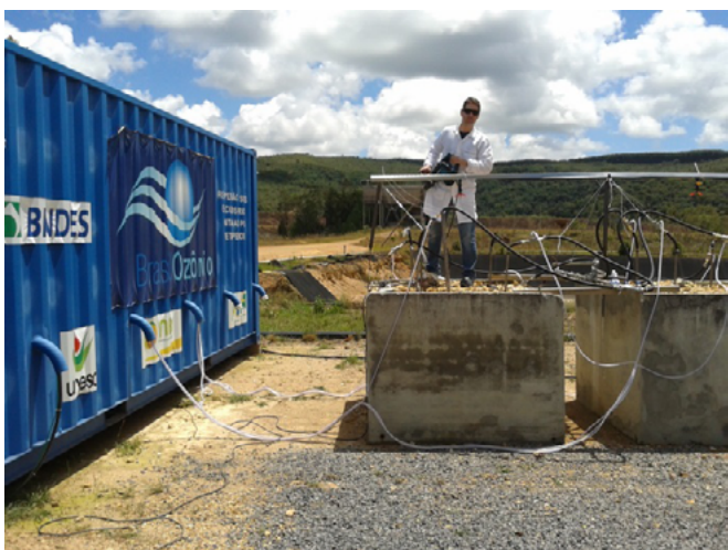
d) Sistema de injeção parcialmente montado.
