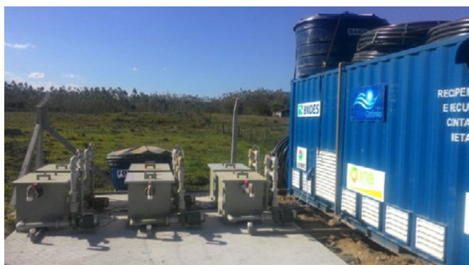
f) Vista geral do container e dos reatores.
