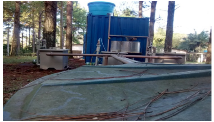
c) Detalhes da planta-piloto.
