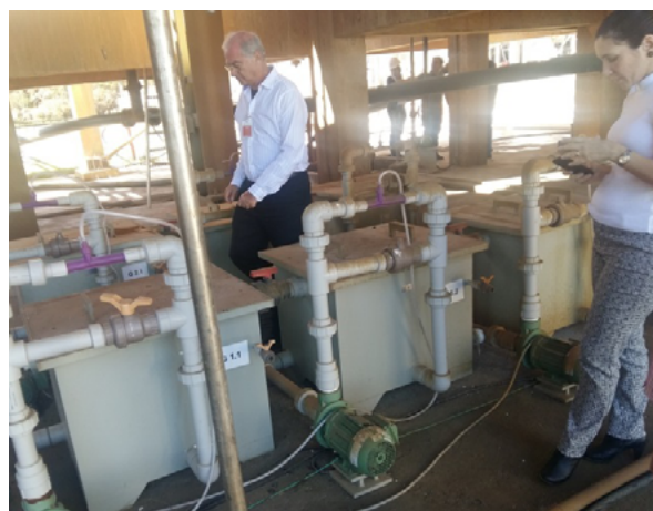
c) Detalhes dos reatores de oxidação.
