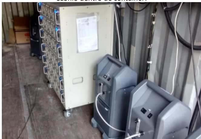
Figura 7 - Posicionamento do gerador e do concentrador de ozônio dentro do container .
