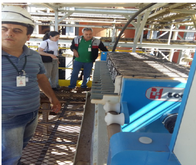
c) Filtro prensa instalado.
