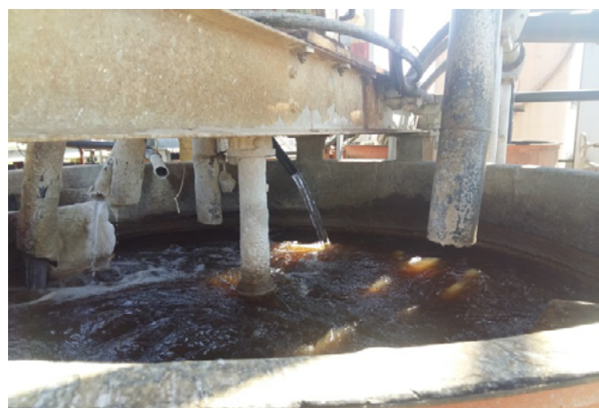
e) Detalhes da adição do hidróxido de cálcio no tanque de neutralização.
