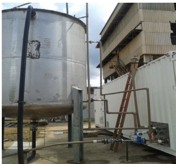
f) Vista geral do tanque de oxidação.
