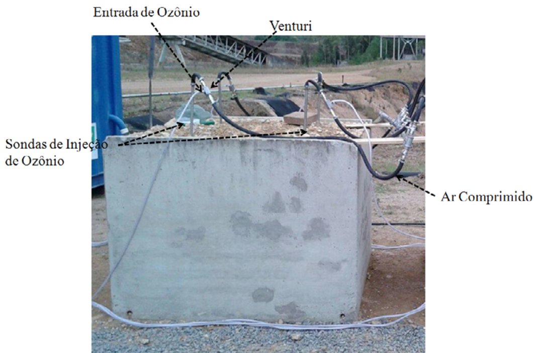
Figura 25 - Foto da pilha-piloto de estéril de mineração de urânio, construída a partir do trabalho realizado com o estéril de mineração de carvão.
