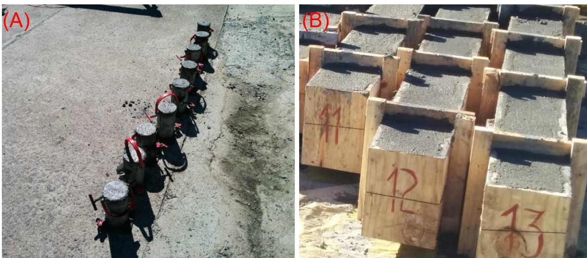
Figura 3: (A) Moldagem dos corpos de prova; (B) Vigas concretadas
