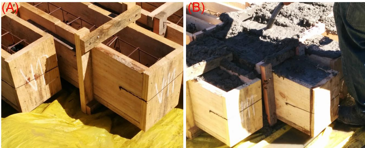
Figura 2: (A) Fôrmas e armaduras posicionadas; (B) Concretagem
