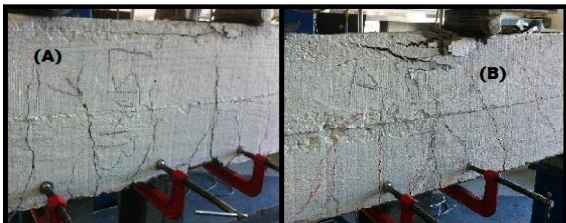
Figura 8: Vigas fissuradas após ruptura espaçamento a três terços.
