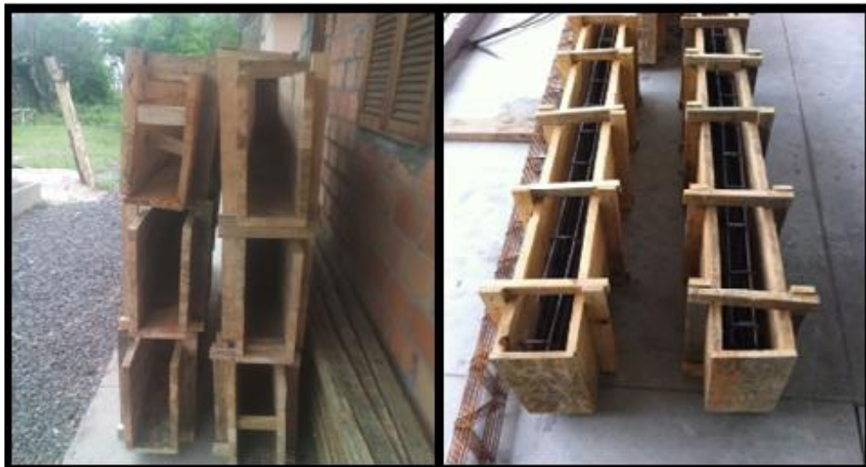
Figura 3: Detalhe das formas e armadura prontas para concretagem.
