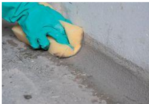
Figura 14 – Detalhe canto boleado inferior da piscina.
