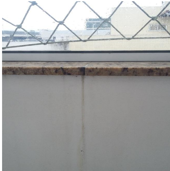
Figura 6 – Emenda de topo entre pingadeiras de granito sem selante.
