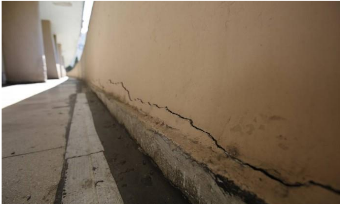
Figura 4 – Fissura no muro da platibanda na altura da emenda manta asfáltica / alvenaria.
