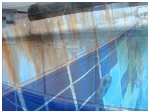
Figura 12 – Bolor em pastilhas cerâmicas em piscina.
