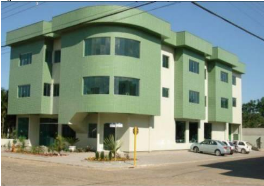
Figura 1 –Atual sede administrativa
