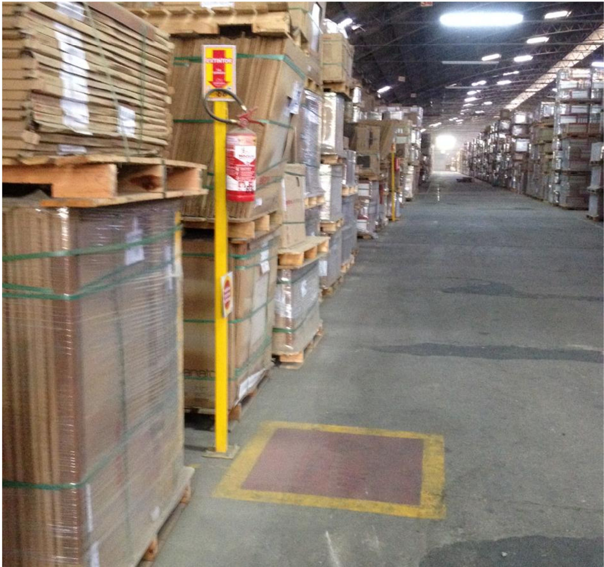
Figura 22: Suporte para afixação dos extintores - setor de expedição.
