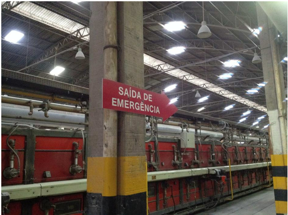
Figura 28: Placas auxiliares de saída de emergência.
