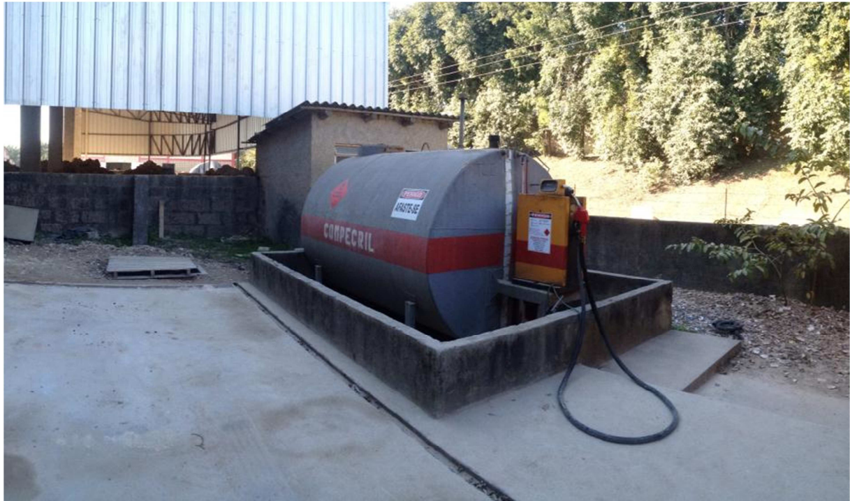
Figura 16: Tanque de combustível – óleo diesel.
