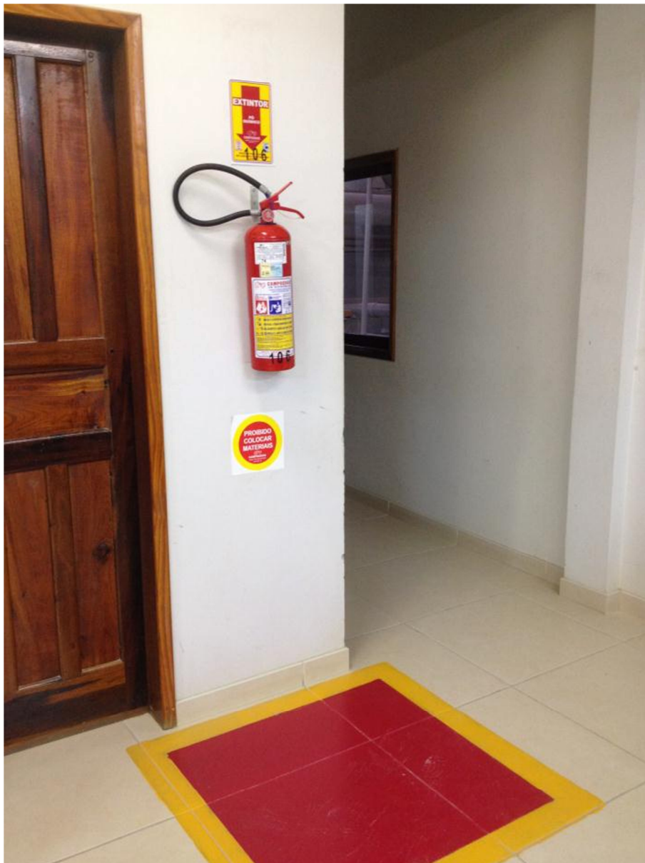
Figura 33: Afixação e identificação de extintores - Escritório fabril.
