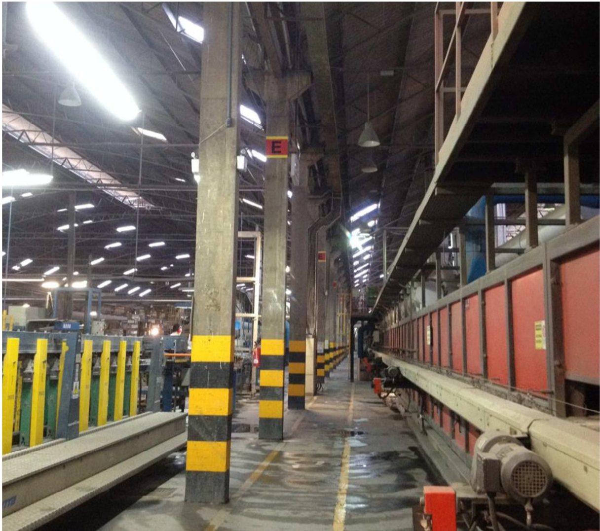
Figura 26: Afixação e identificação de extintores - Setor classificação.
