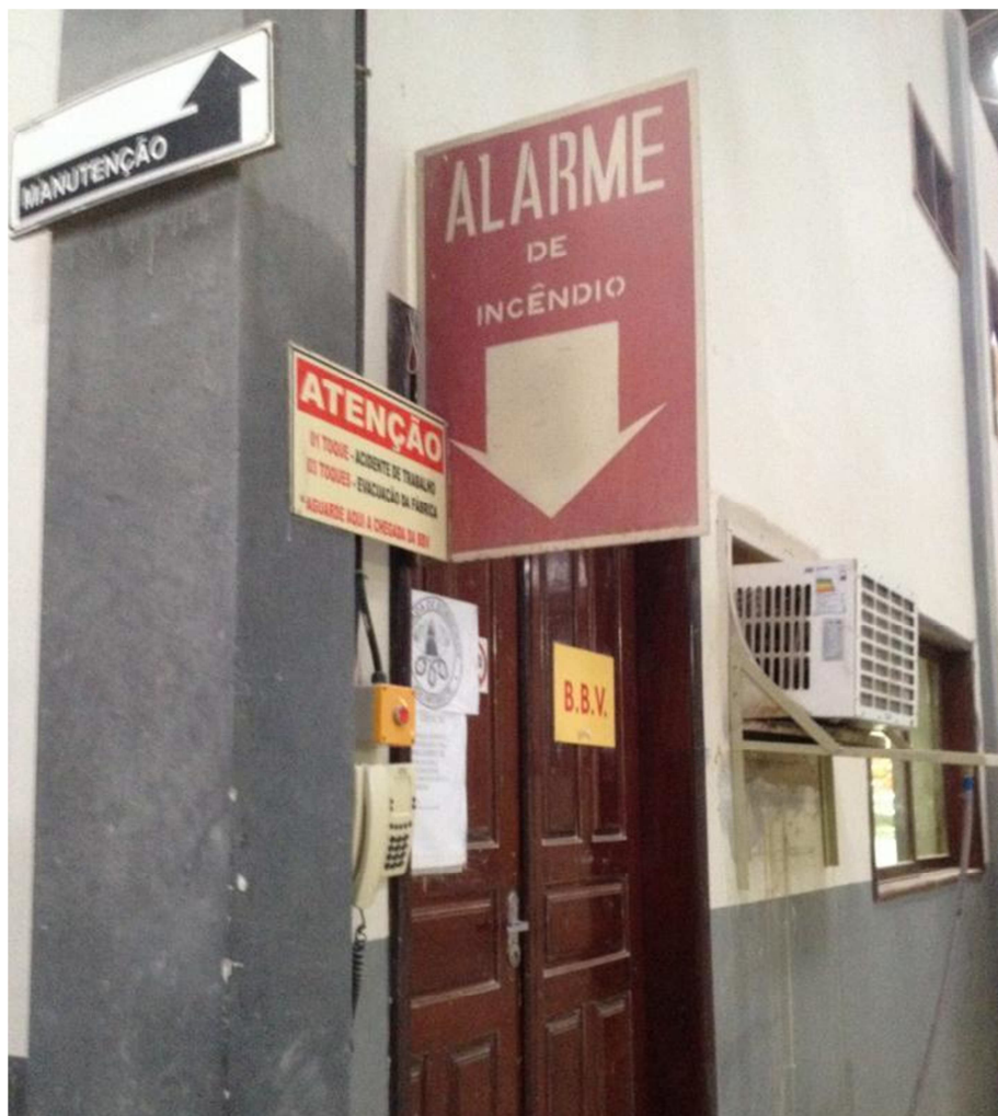
Figura 30: Sala da Brigada de Bombeiros Voluntários - Alarme de emergência.
