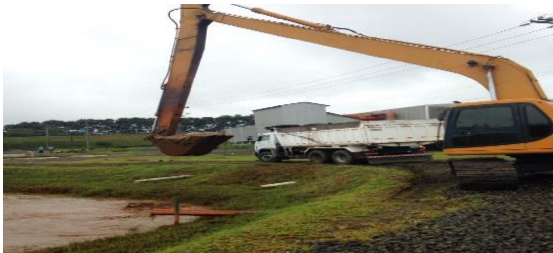
Figura 11- Limpeza da bacia de captação.
