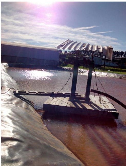
Figura 10- Balsa de apoio da bomba de lodo.
