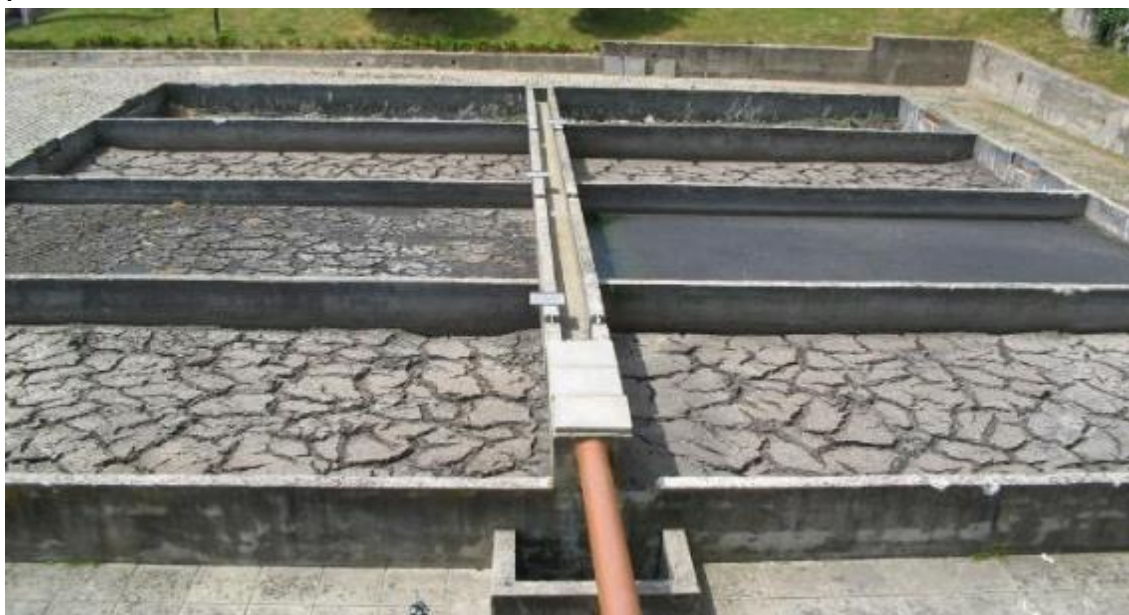
Figura 2- Leito de secagem típico de estações de tratamento de esgoto
