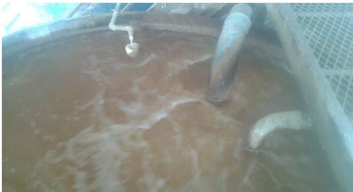
Figura 8- Sistema de sopradores para oxidação dos íons ferrosos e agitação turbulenta.
