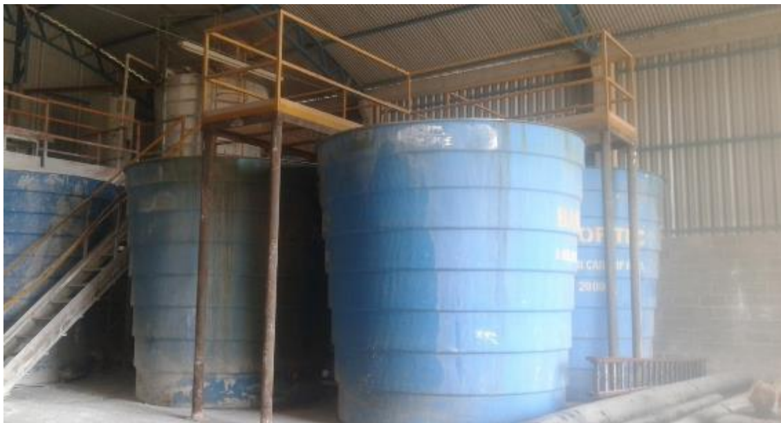
Figura 6- Sistema de adição de cal.
