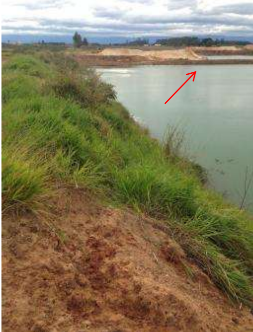
Figura 4: Talude parcialmente formado e talude da lateral parcialmente recuperado.
