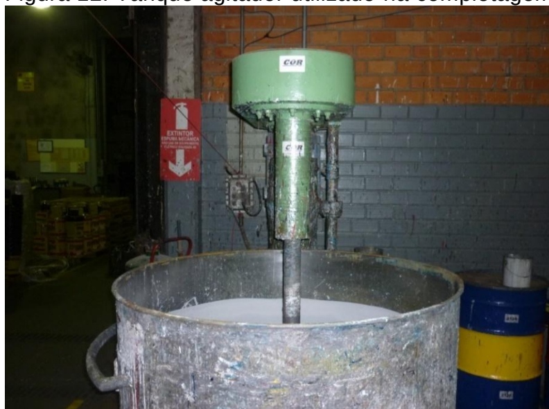
Figura 12: Tanque agitador utilizado na completagem.
