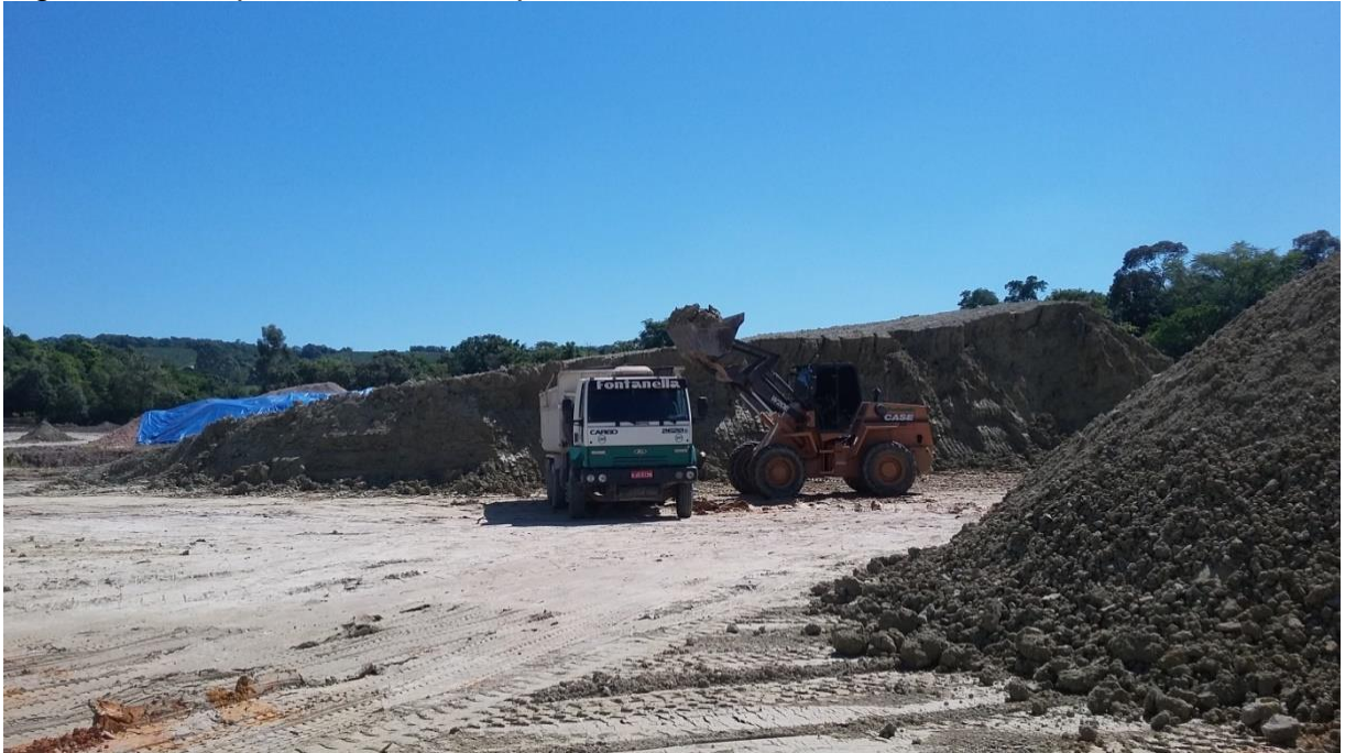
Figura 30 – Depósito de matéria prima
