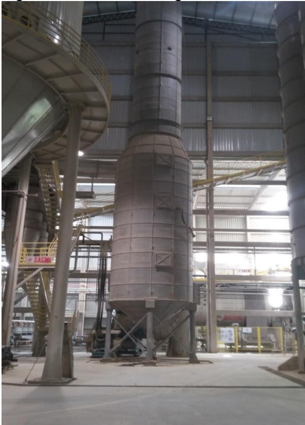
Figura 10 – Lavador de gases
