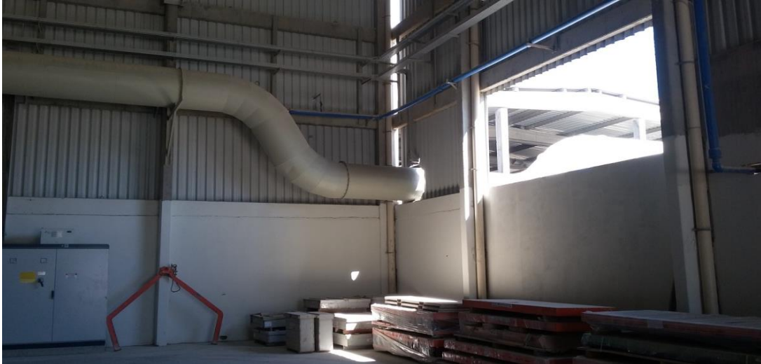
Figura 26 – Duto filtro de mangas
