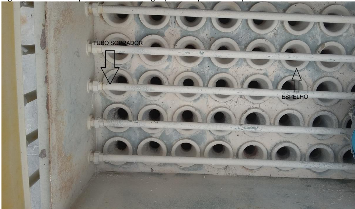
Figura 34 – Parte superior filtro de mangas, tubo soprador e espelho
