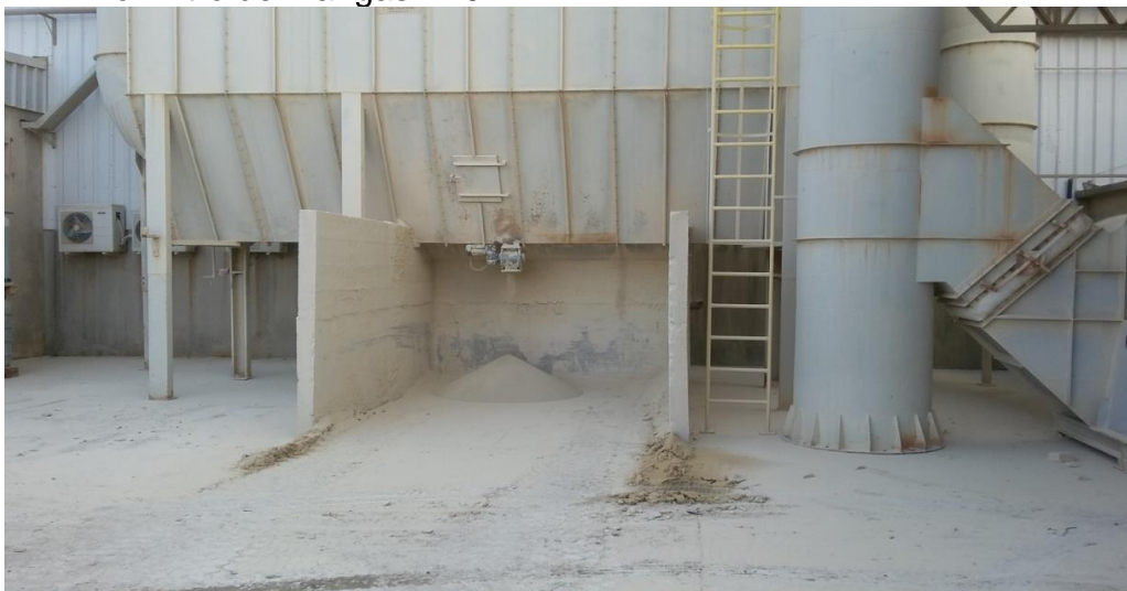
Figura 27 – Box filtro de mangas nº 02
