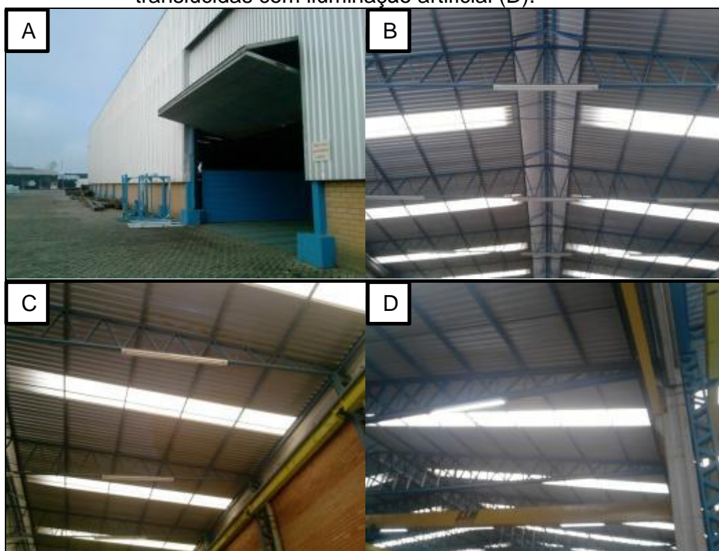
Figura 15 – Abertura de entrada/saída de ar – portão (A); Lanternim (B); Telhas translúcidas sem iluminação artificial (C); Telhas translúcidas com iluminação artificial (D).
