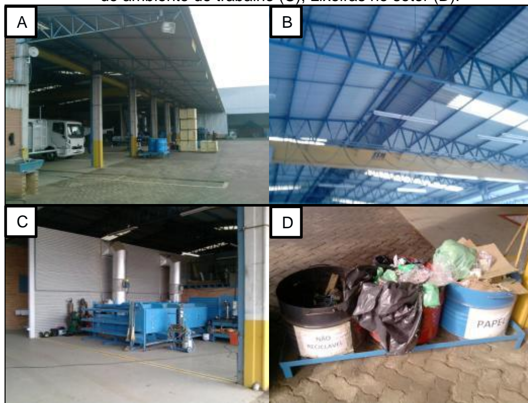
Figura 34 – Abertura de entrada/saída na etapa de adaptações do caminhão e montagem final, hidráulica e acabamento (A); Lanternim e lâmpadas na etapa de adaptações do caminhão e montagem final, hidráulica e acabamento (B); Organização do ambiente de trabalho (C); Lixeiras no setor (D).
