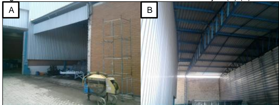
Figura 24 – Aberturas na estrutura no ambiente de lavação (A) (B).
