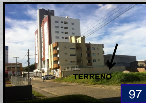
Figura 97 – Edifícios residenciais próximos ao terreno Fonte: Autora (2014)
