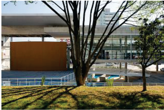
Vista da praça em direção ao centro digital. Nessa fachada da biblioteca, prevalece a transparência. Fonte: < http://www.arcoweb.com.br >
