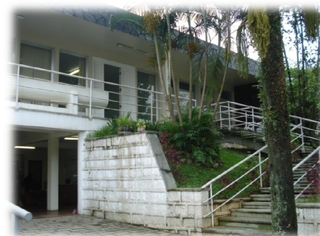
Imagens 22 e 23: Acesso ao CAPS III. Possui rampa na lateral, diferentemente do CAPS II. Fonte: arquivo pessoal
