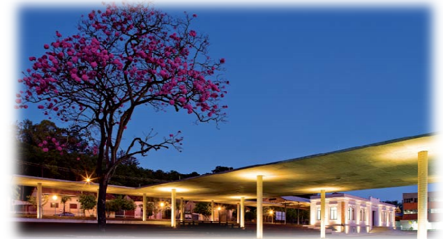
Imagem 52: Marquises no acesso principal.
