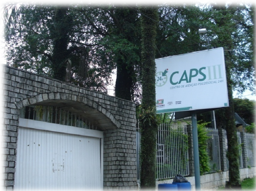
Imagem 18: Vista externa – CAPS III Fonte: arquivo pessoal
