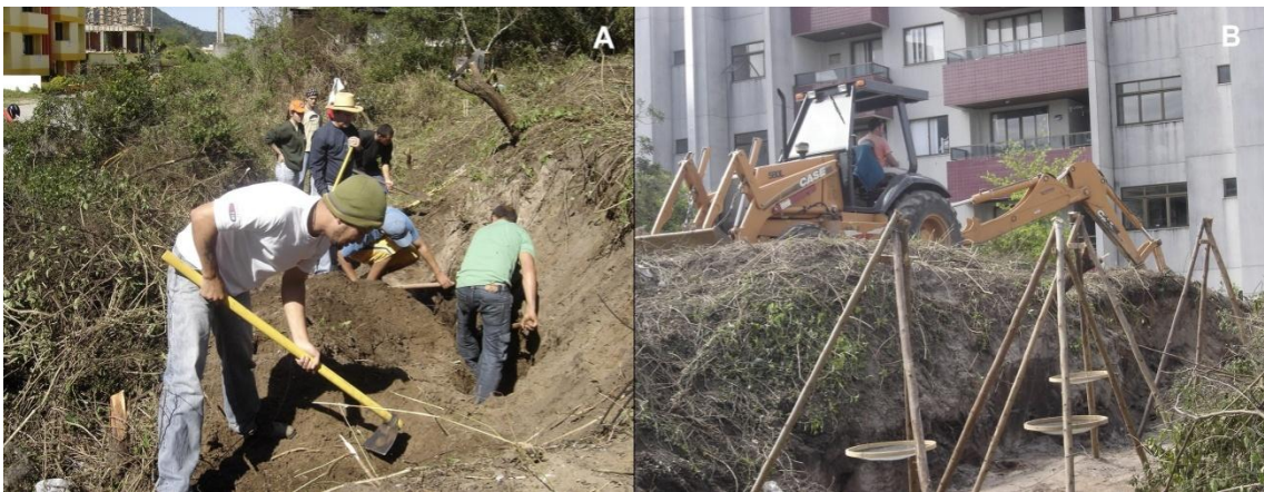
Figura 3 - A) atividade de limpeza do terreno do presente estudo; B) uso de retroescavadeira para limpeza do local. Fonte: acervo IPAT/UNESC.
