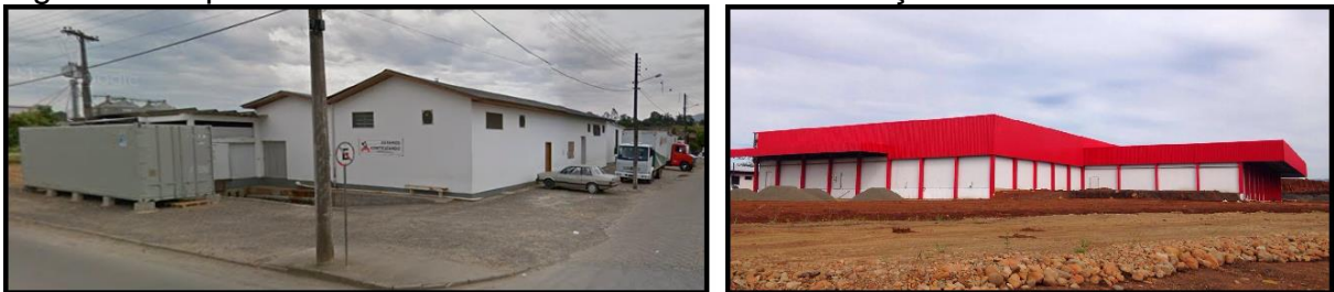
Figura 4: Empresa Laticínios Veneza: atual e em construção
