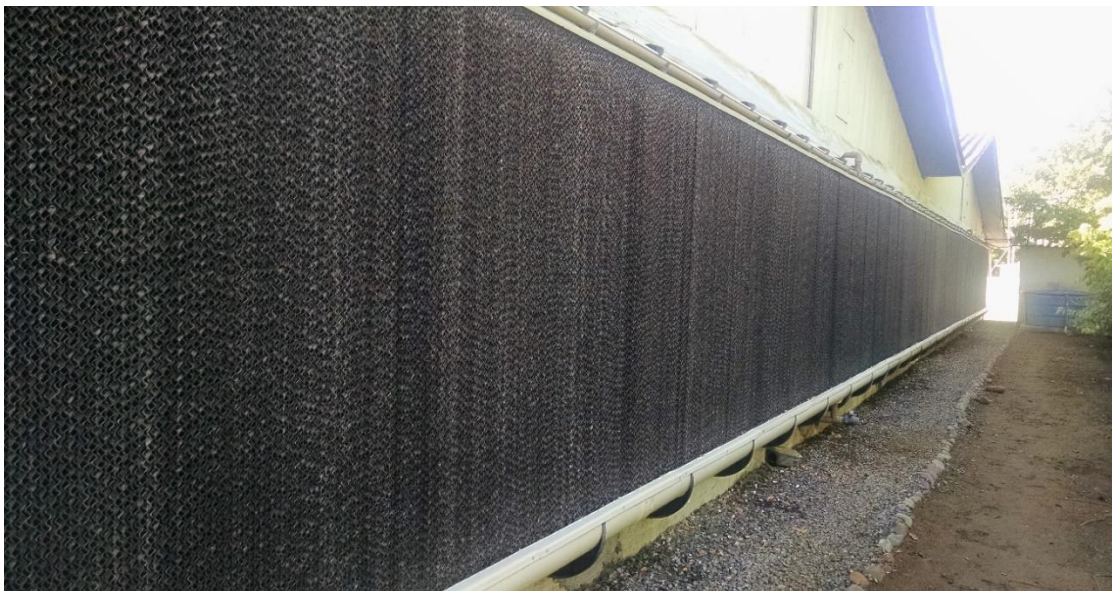
Figura 4 - Painel Evaporativo Instalado em um Galpão na Cidade de Forquilha - SC
