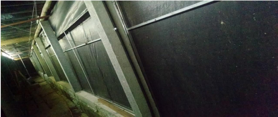
Figura 5 - Modificações Necessárias para instalação do Painel
