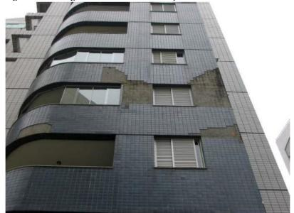
Figura 5 - Vista geral da fachada com desplacamento
