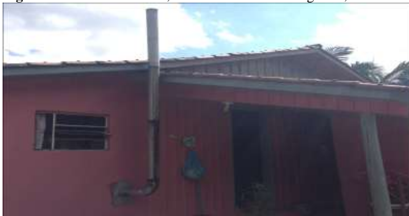
Figura 11 - Casa Reformada, Localidade de Vila Progresso, Turvo.
