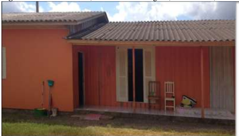
Figura 8 – Casa Reformada, localidade Estrada geral, Morro Chato, Turvo.
