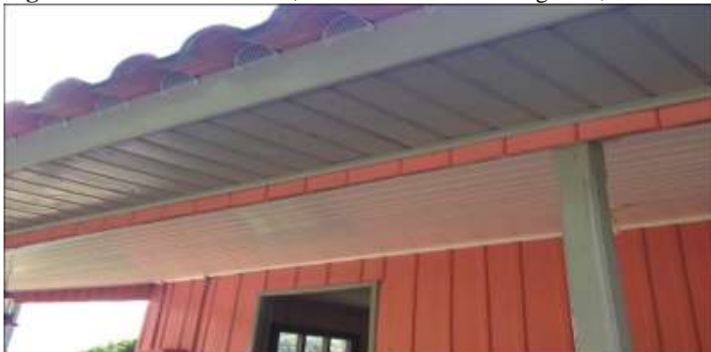
Figura 12 - Casa Reformada, Localidade de Vila Progresso, Turvo.
