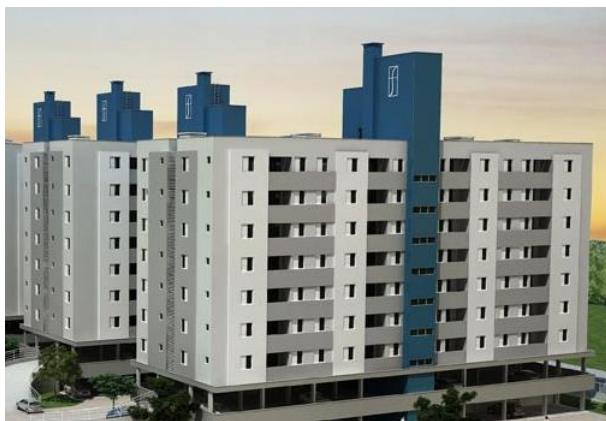
Figura 10 – Edifício Residencial Nações Unidas.
