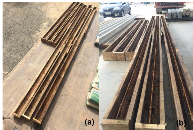
Figura 5: Fôrmas prontas (a); Armadura posicionada (b)
