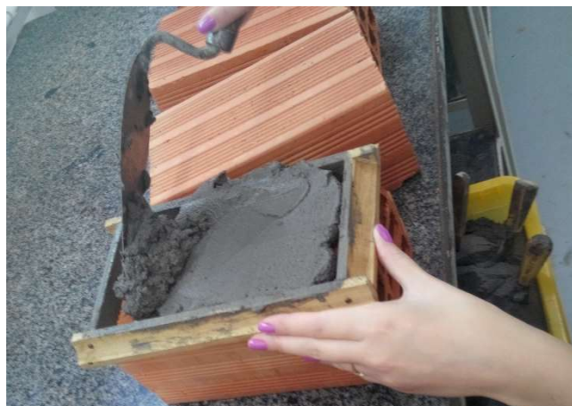
Figura 03: Aplicação da argamassa de revestimento
