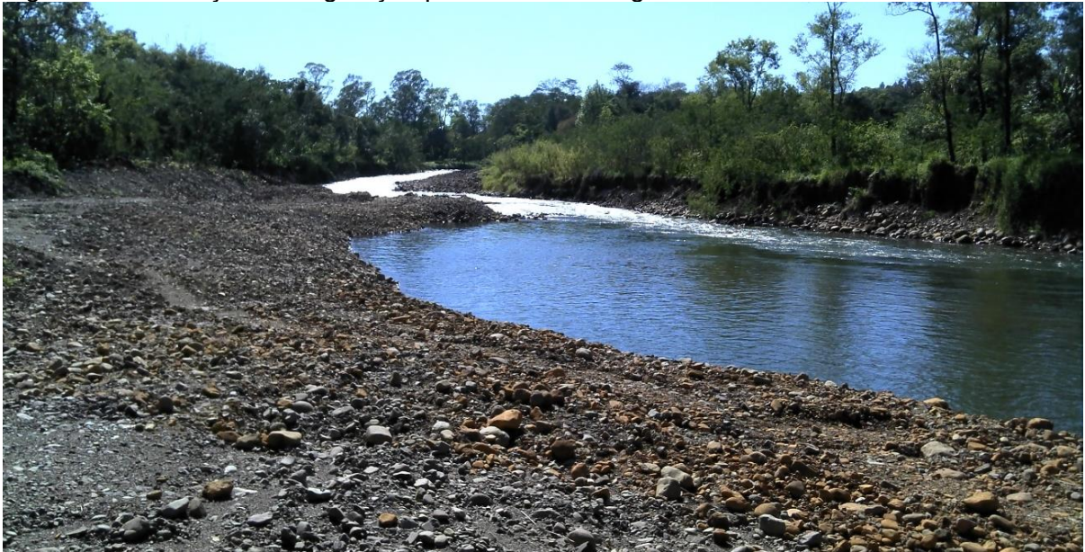
Figura 32 - Remoção da vegetação presente nas margens.
