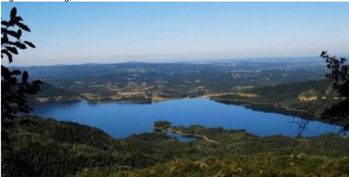
Figura 7 - Barragem do Rio São Bento
