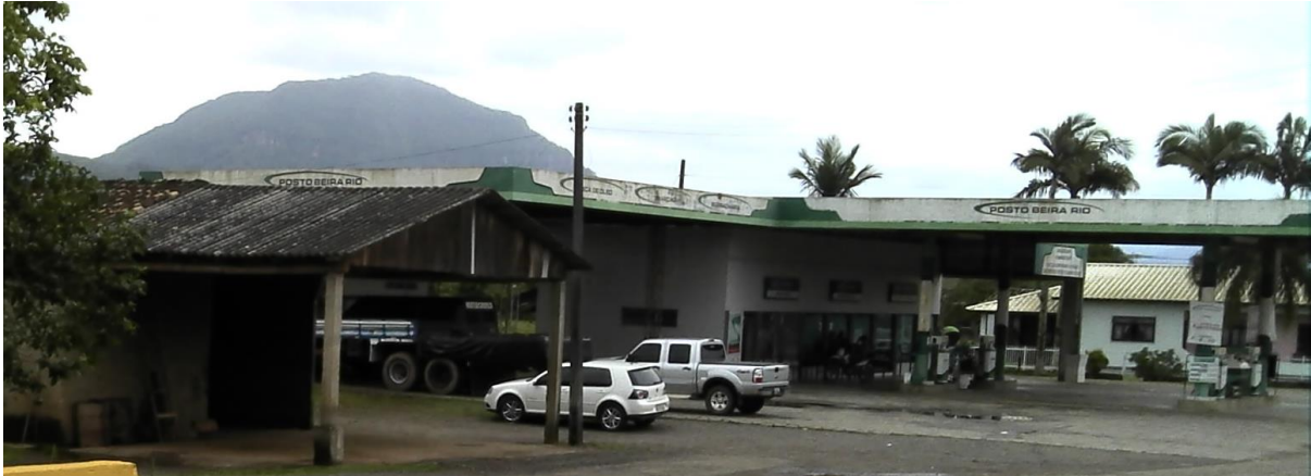
Figura 36 - Posto de gasolina e borracharia situados em área urbana na APP do segmento em estudo.
