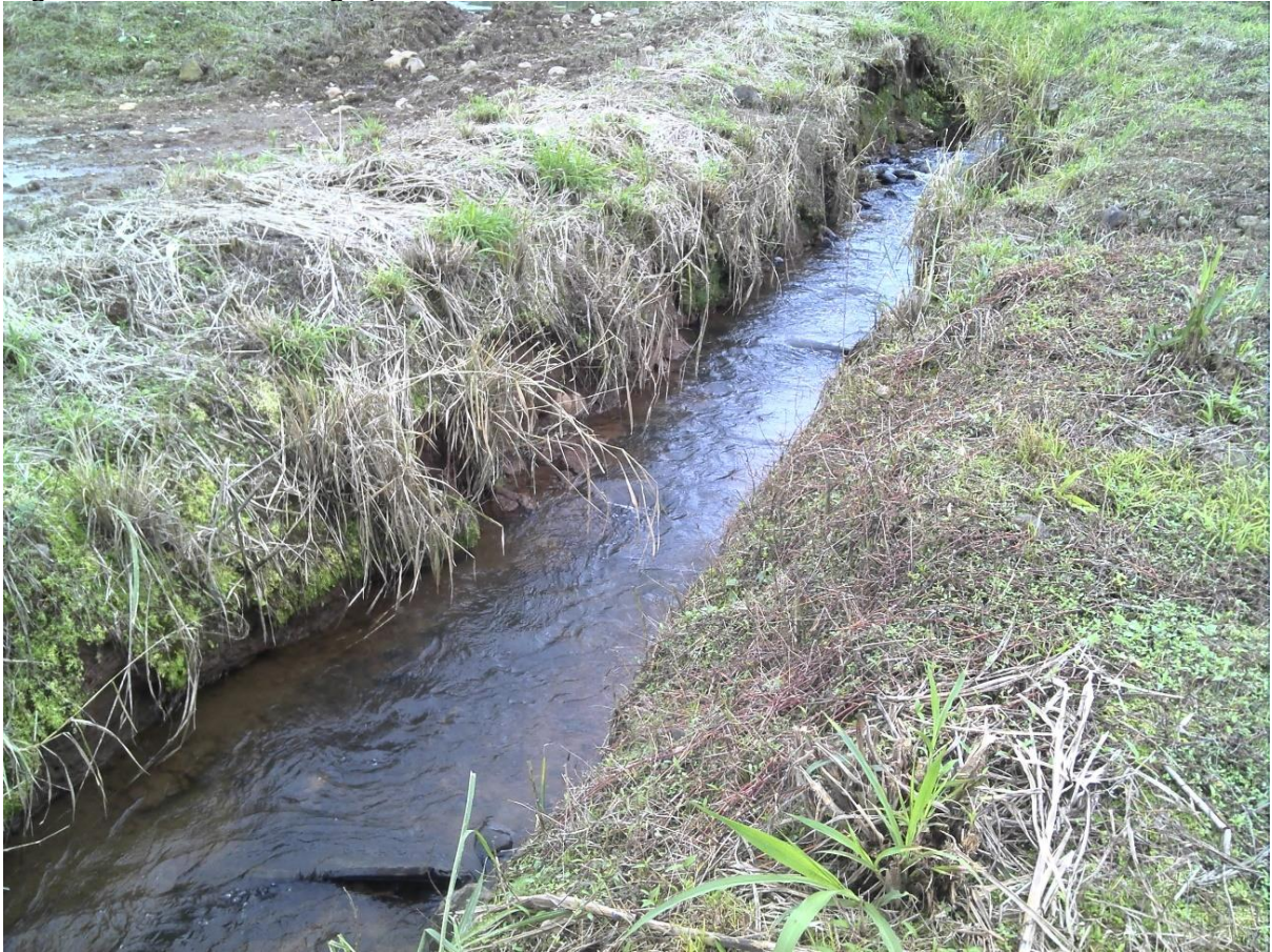
Figura 30 - Canal de irrigação à céu aberto.
