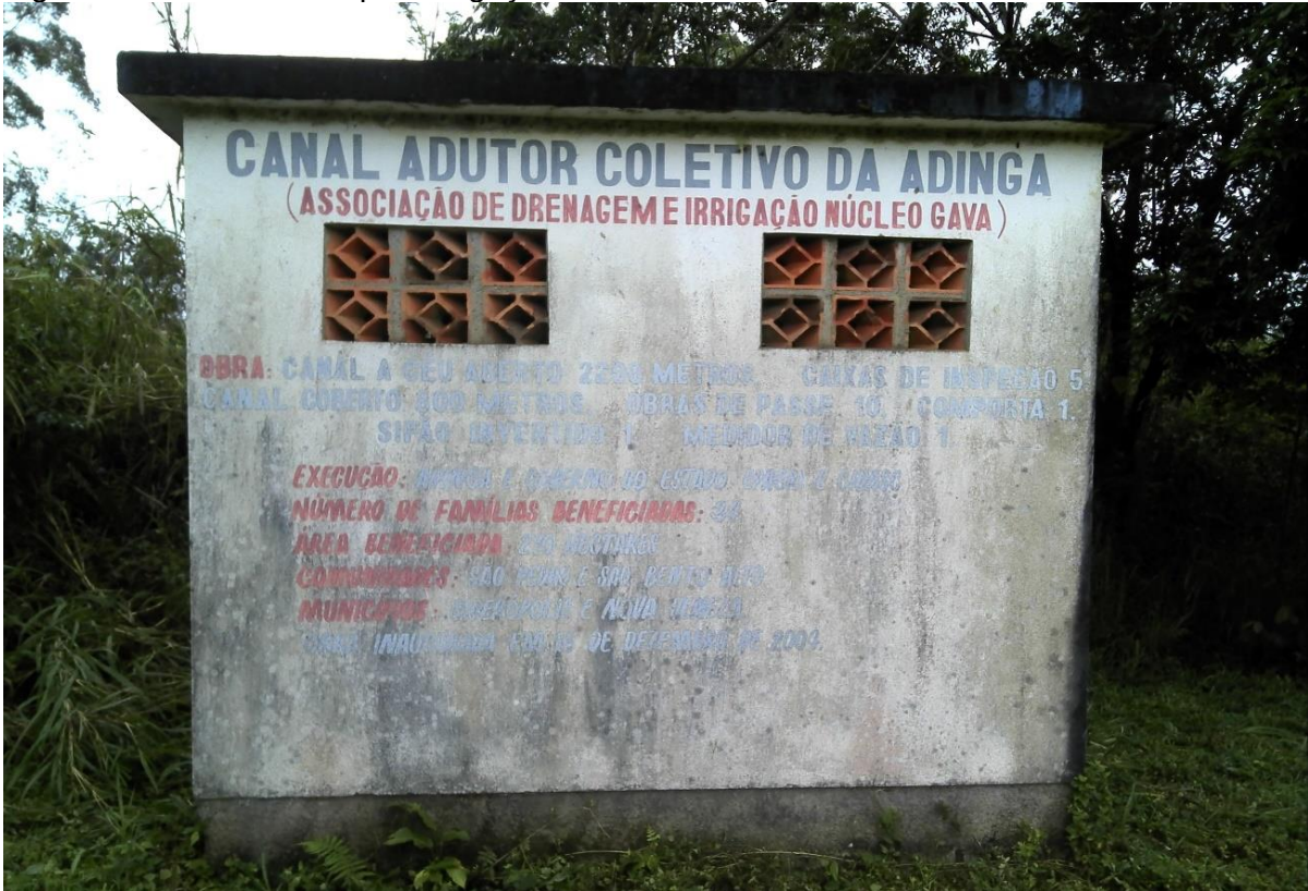
Figura 28 - Canal adutor para irrigação das culturas agrícolas.
