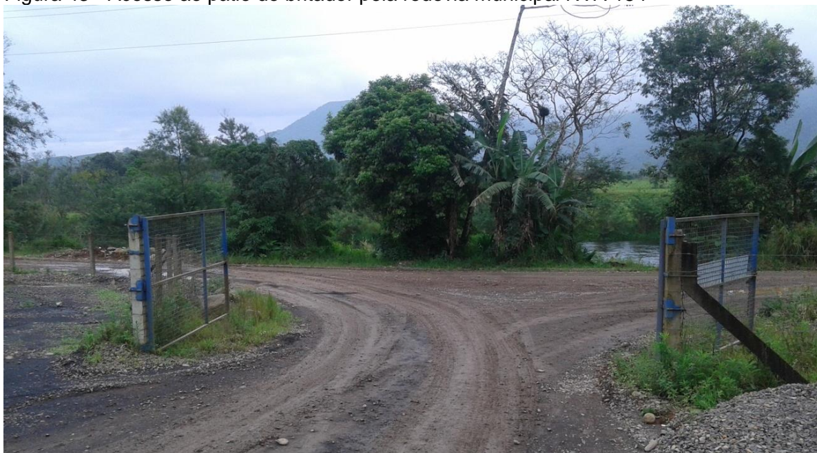
Figura 43 - Acesso ao pátio do britador pela rodovia municipal NVA 154
