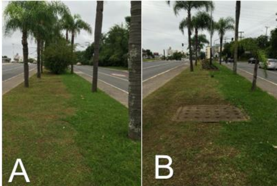
Figura 61 – Imagens do Trecho 3, após a parada de ônibus.
