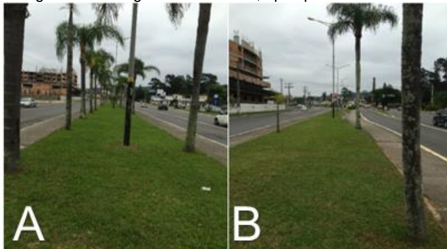
Figura 51 – Imagens do Trecho 1, após parada de ônibus.
