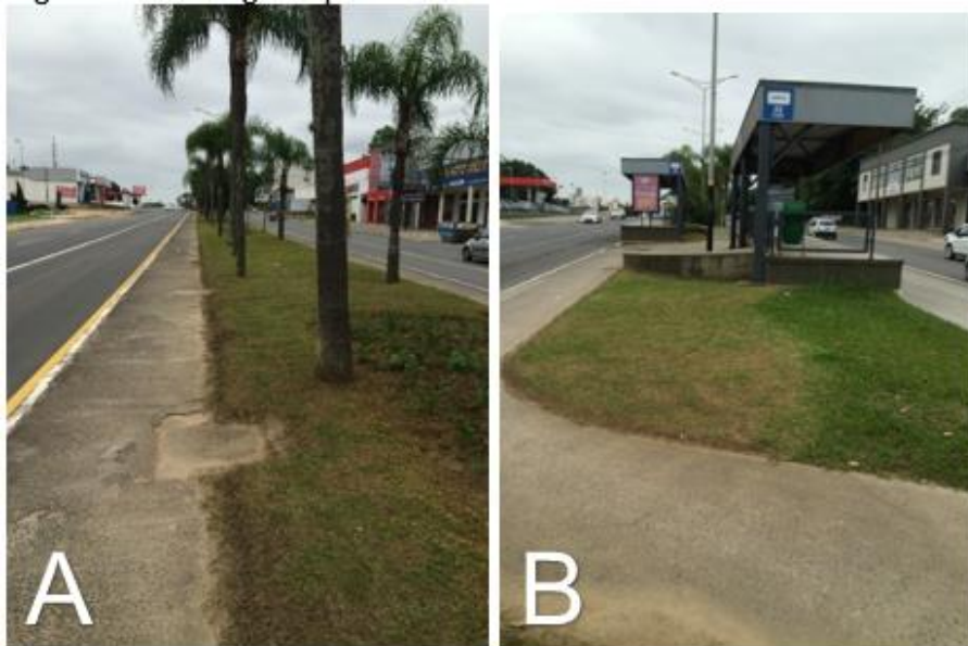
Figura 60 – Imagens parciais do Trecho 3.
