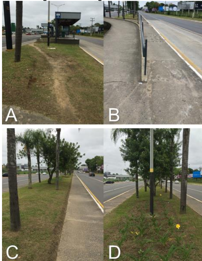
Figura 58 - Imagens do Trecho 3.
