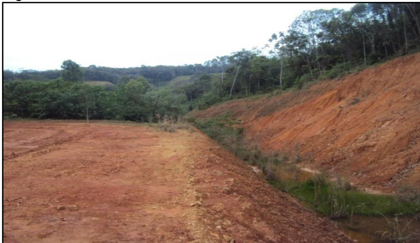
Figura 10: Canal de desvio.
