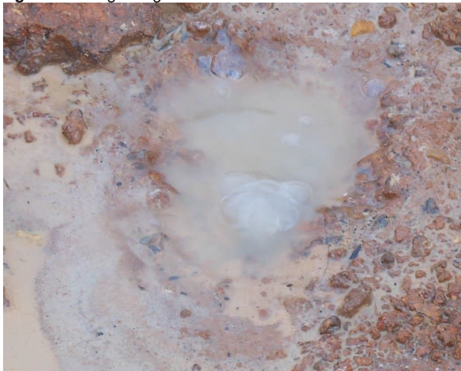
Figura 11 - Fuga de gás metano no aterro sanitário do Cirsures.
