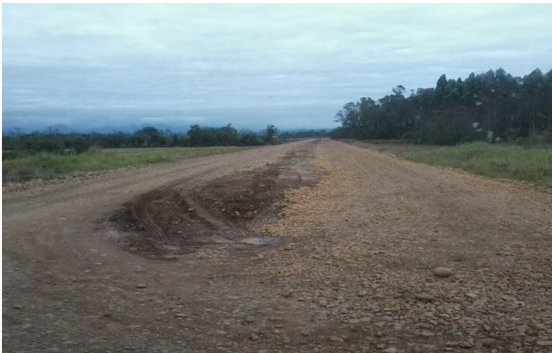
Figura 16: Foto da Av Eurico Back em construção. Fonte: Prefeitura municipal de Forquilha.
