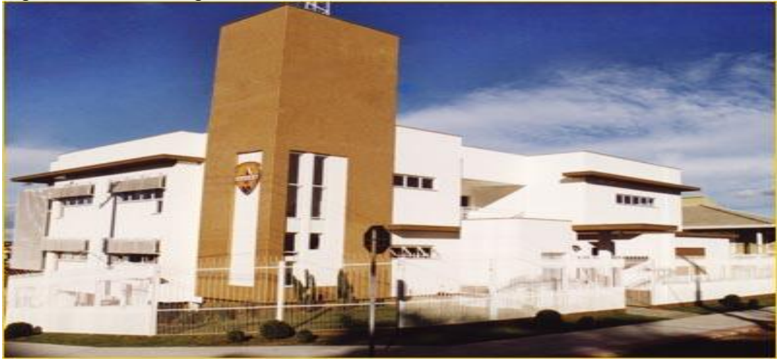
Figura 08 - Sede Vigilância Radar.
