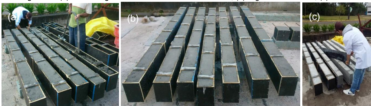
Figura 07: (a) Concretagem utilizando vibrador de imersão; (b) Vigas concretadas; (c)
