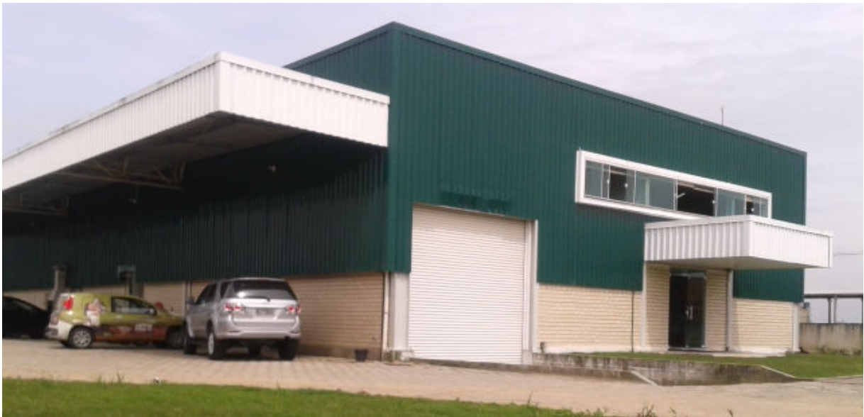
FIGURA 2: Edificação utilizada para estudo de caso.
