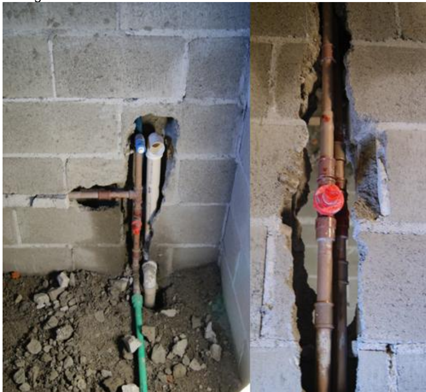
Fotografia 2: Corte em alvenaria estrutural.
