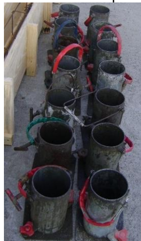
Figura 3: Moldes dos corpos de prova para ensaio de compressão axial, resistência à tração por compressão diametral e módulo de elasticidade prontos para concretagem.
