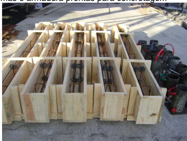
Figura 1: Foto das formas e armadura prontas para concretagem
