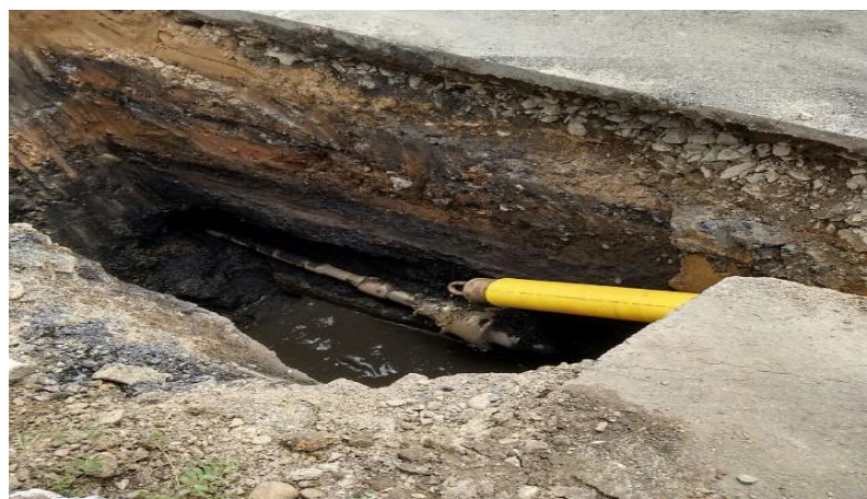
Figura 1: Furo piloto e puxamento da tubulação
