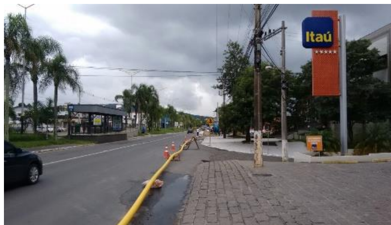
Figura 2: Preparação e disposição da tubulação de PEAD
