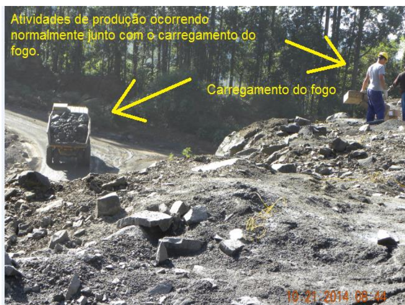
Figura 5 - Processo de carregamento dos furos da bancada com os explosivos.
