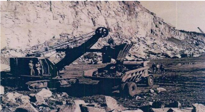
Figura 10 – Início da construção do Porto de Imbituba.
