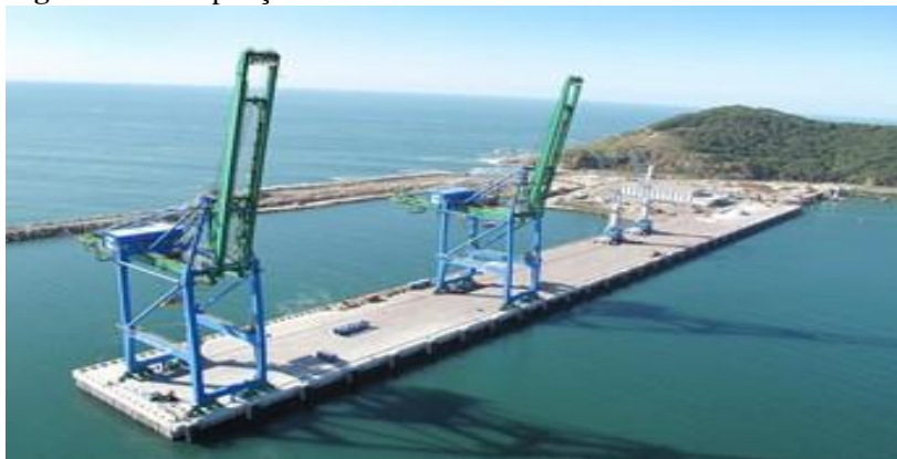
Figura 26 – Ampliação de cais acostável.
