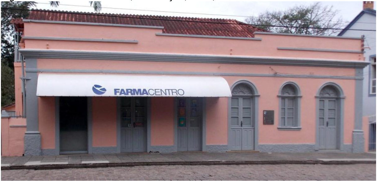
Figura 12 – Casa Iva Damian, construção, 1896, 2015.
