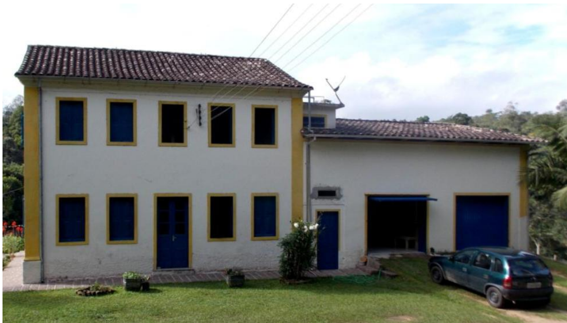
Figura 5 – Casarão da Família Boccardo, construção 1921, 2015.
