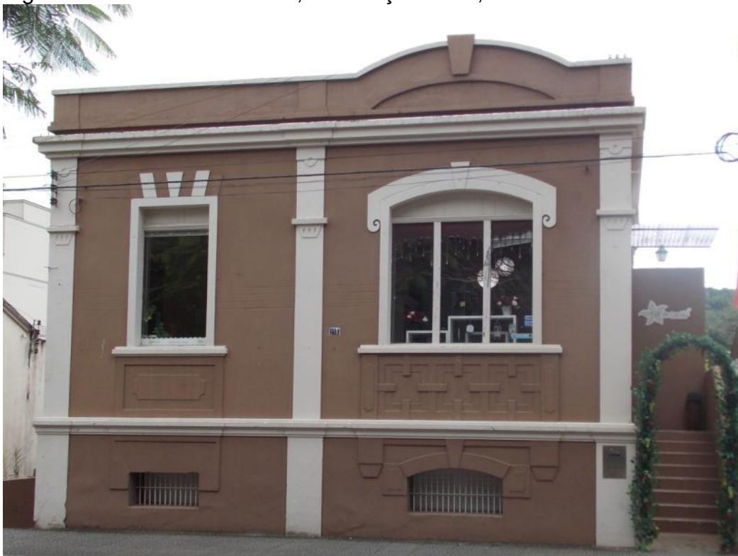
Figura 23 – Victório Bez Batti, construção 1925, 2015.
