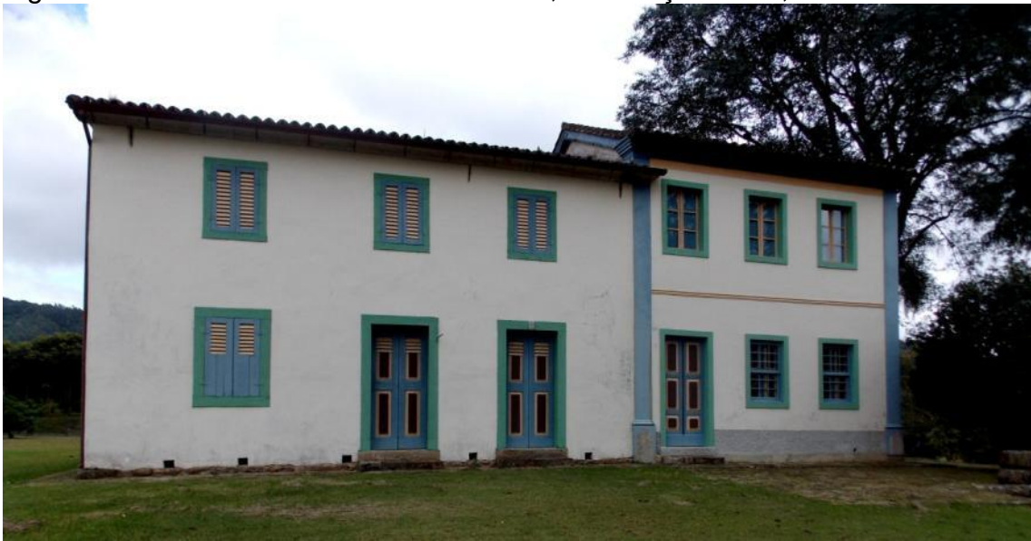
Figura 21 – Casarão da Família Mazzucco, construção 1912, 2015.
