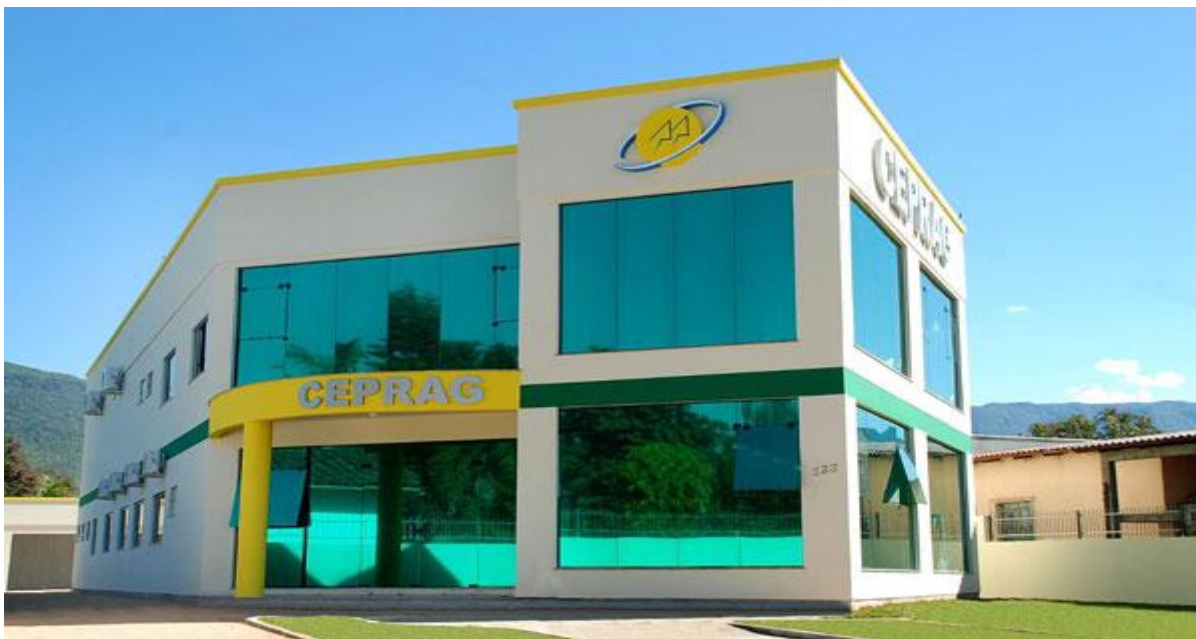
Figura 1 - Sede da Empresa CEPRAG em Praia Grande, Santa Catarina.
