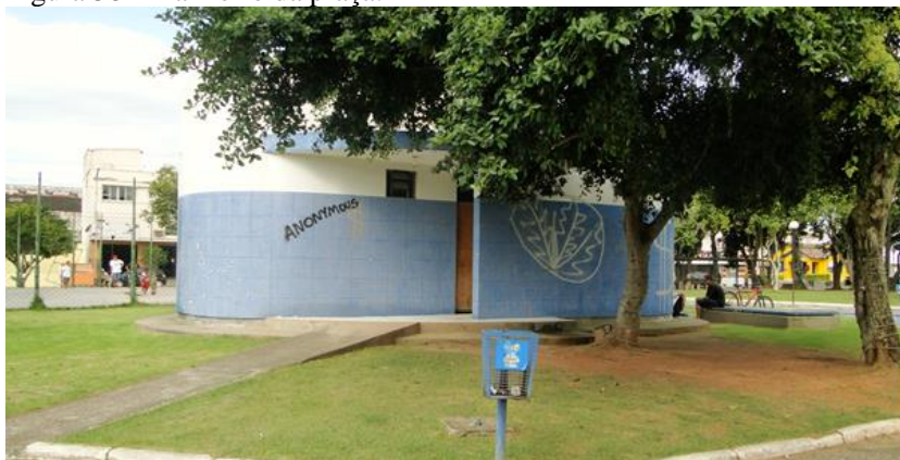
Figura 38 – Banheiro da praça.
