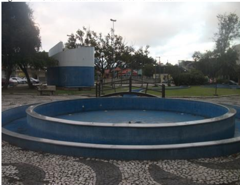
Figura 45 – Chafariz desativado – não conformidade.
