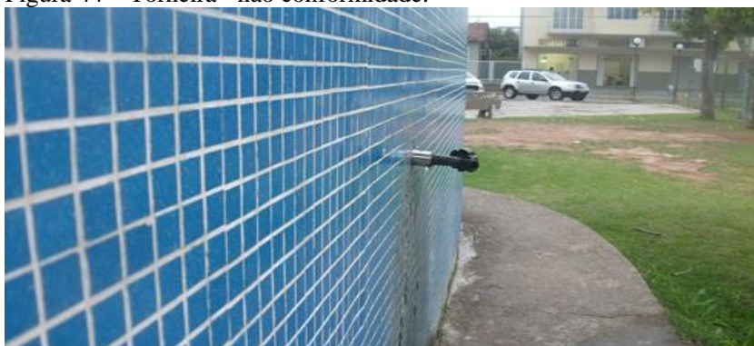
Figura 44 – Torneira - não conformidade.
