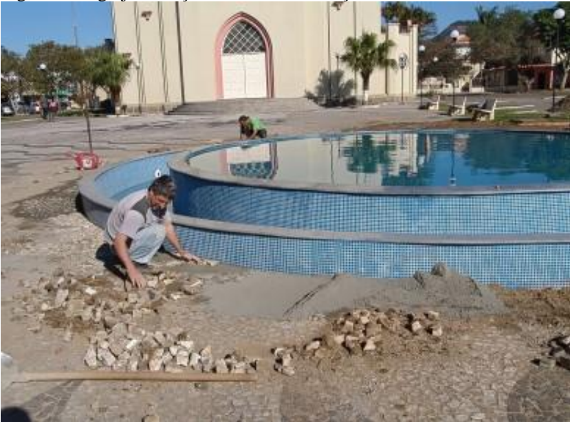
Figura 14 - Igreja e Praça antes da revitalização.
