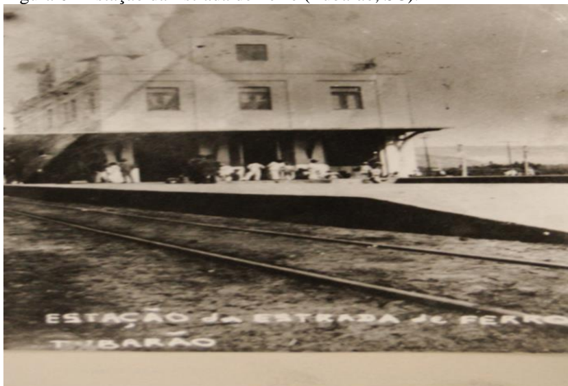
Figura 6 - Estação da Estrada de Ferro (Tubarão, SC).
