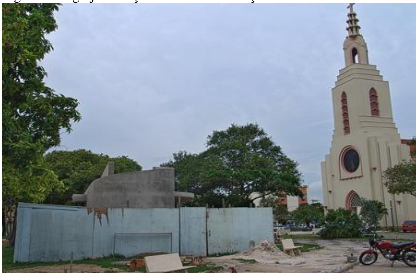
Figura 15 - Igreja e Praça antes da revitalização.
